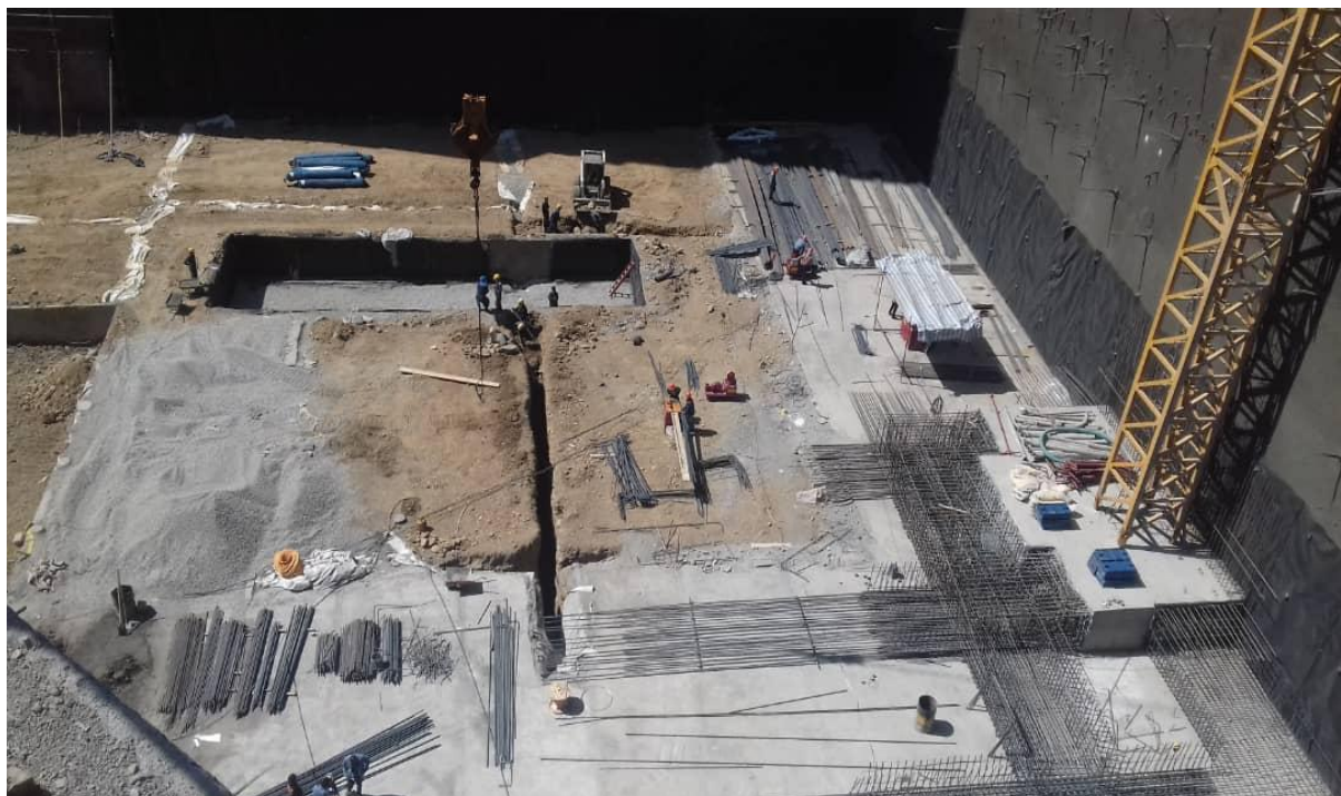
عملیات زهکشی و فونداسیون در فروردین ماه
