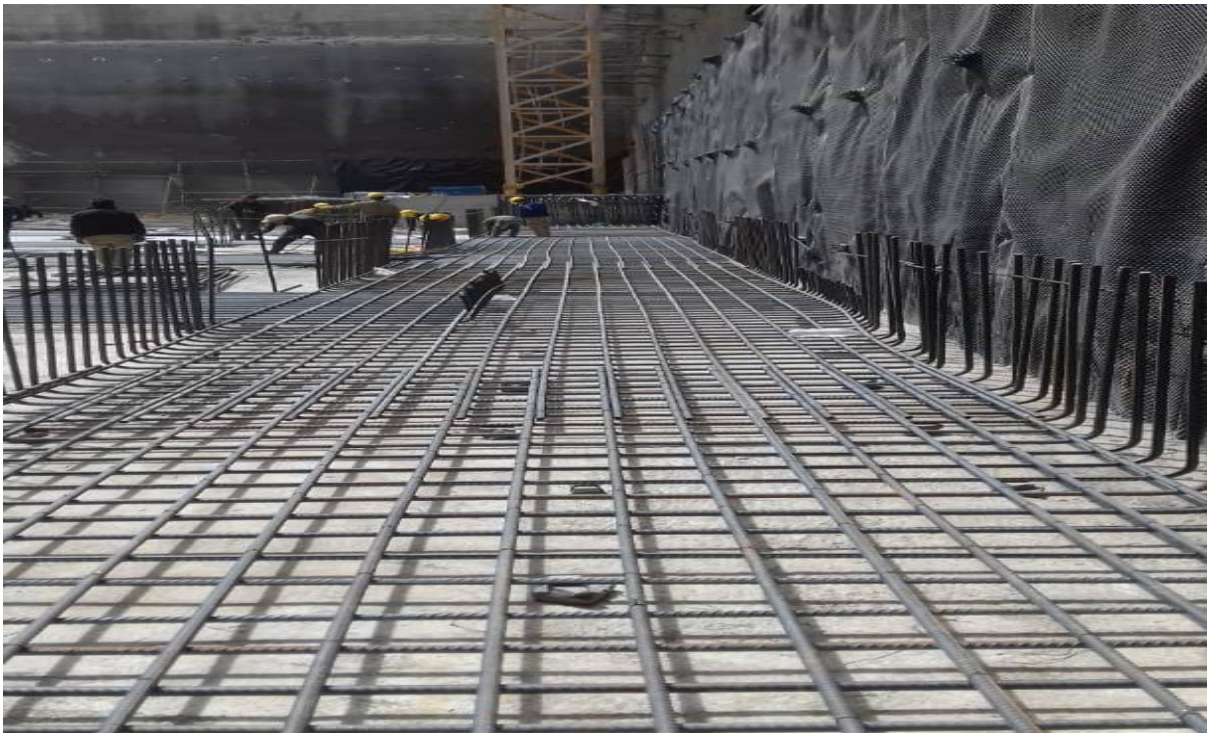
عملیات زهکشی و فونداسیون در فروردین ماه
