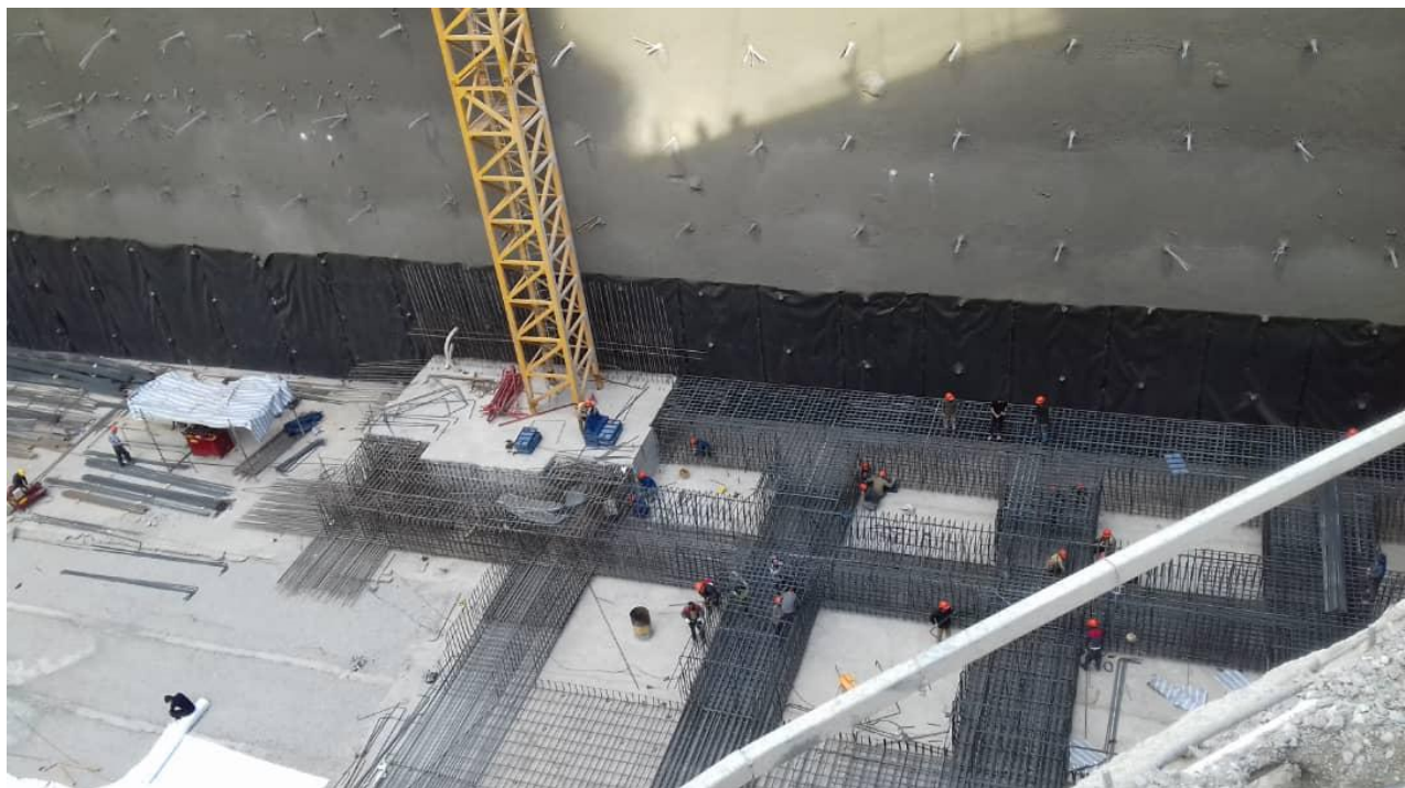
عملیات نصب تاورکرین در ضلع شمالی سایت در فروردین ماه
